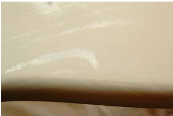
Bild 7: När man mellanslipar tar man bort de sista ojämheterna på ytan. Slipa tills hela ytan är matt, men slipa inte igenom färgen!
